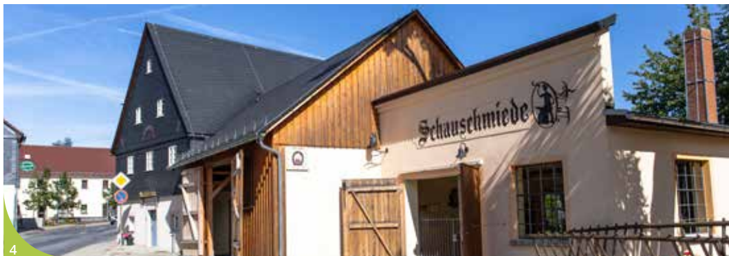
4 Alte Schmiede Rammenau
